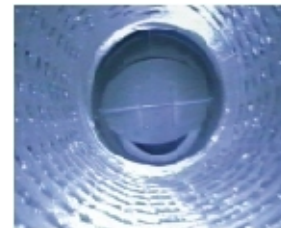
Воздуховод после очистки
